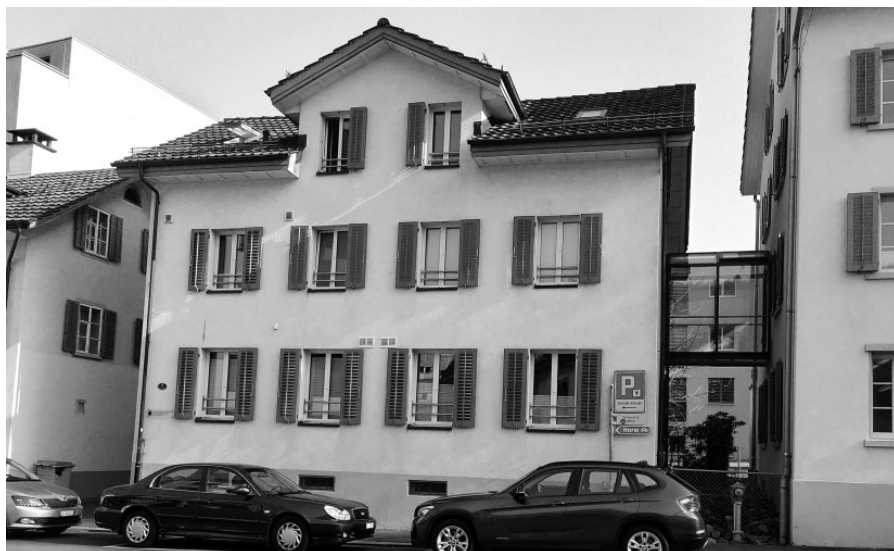
Das Haus Fenkernstrasse 11 wurde umgebaut und saniert und dient nun der Kinder- und Jugendpsychiatrie der lups mit Therapie- und Büroräumen.
