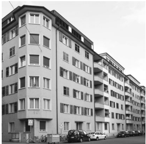
Die Häuser Ulmenstrasse 10 (vorne) und 8 bedürfen einer energetischen Sanierung.
