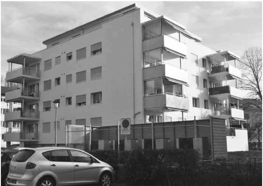
Beim Gärtnerweg 6 sind die grösseren Balkone gut zu erkennen. Im Vordergrund die Wärmepumpen für Heizung und Warmwasser.
