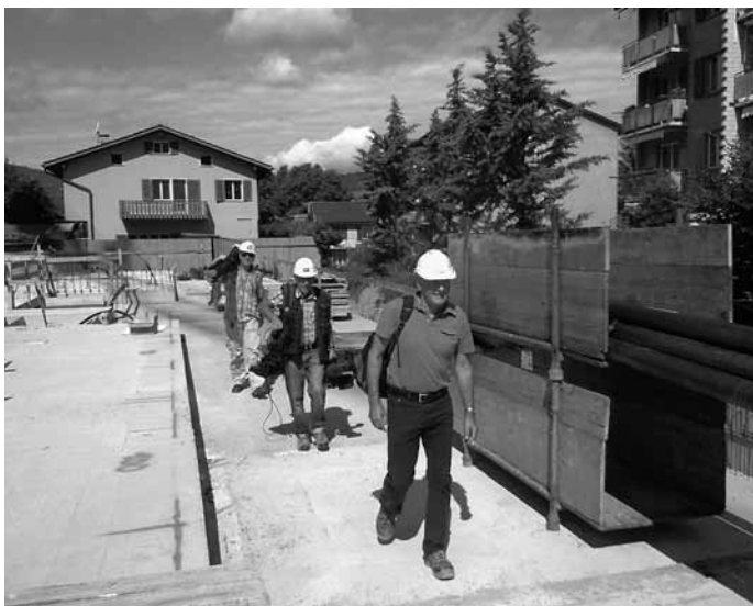
Bauleiter Hans Wegmüller führt die Fernsehcrew sicher über die Baustelle.
