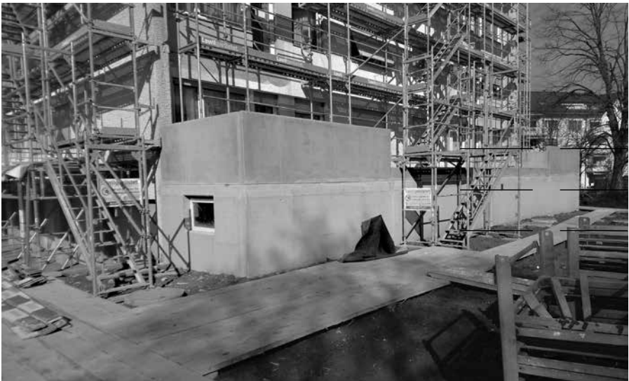
Der Anbau an der Südfassade des Gärtnerwegs 6 mit den daraufliegenden Balkonen konnte noch 2017 realisiert werden. Im Frühjahr 2018 begann die Fassaden- und Strangsaniegung.
